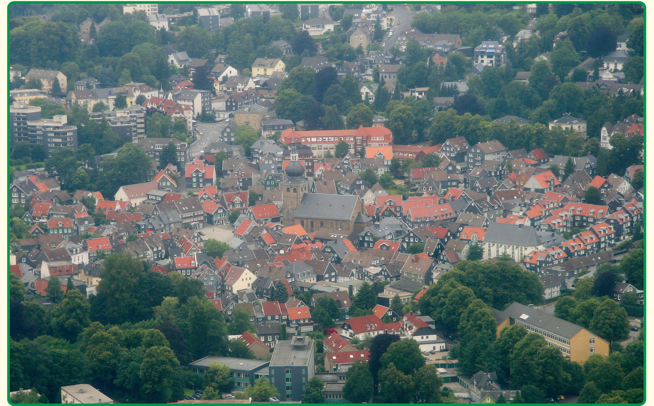
Altstadt Lennep, Luftbildschrägaufnahme
